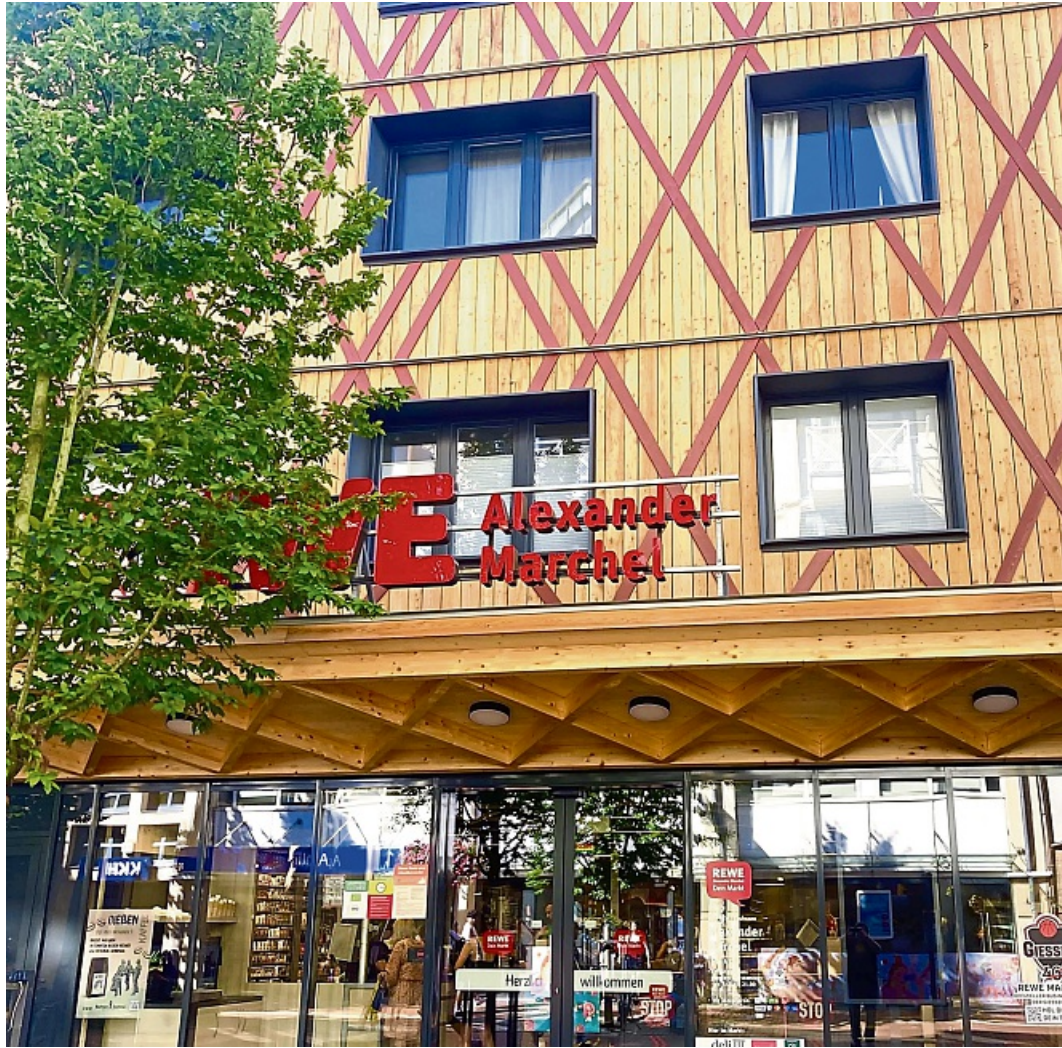
Tendenz steigend: Der Rewe-Markt sorgt für Frequenz im Seltersweg.
