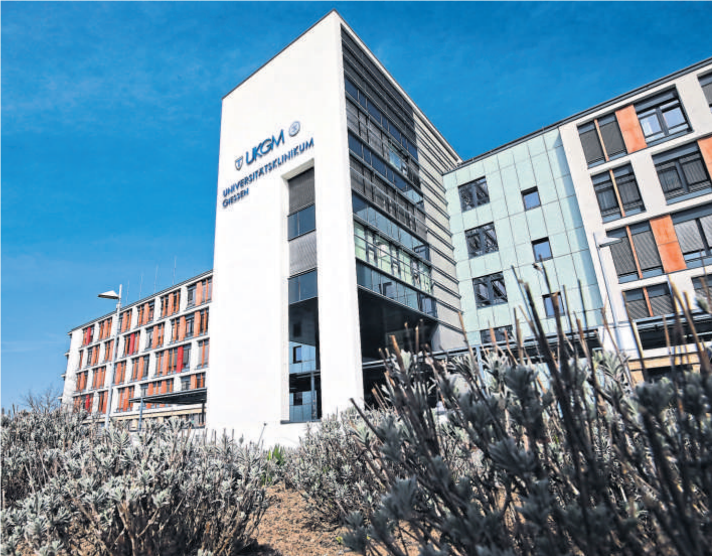
Demnächst sollen die Arbeiten zur Erweiterung des UKGM beginnen.
